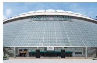
東京ドーム様 監督室、ロッカールーム、観客トイレなど114台導入
